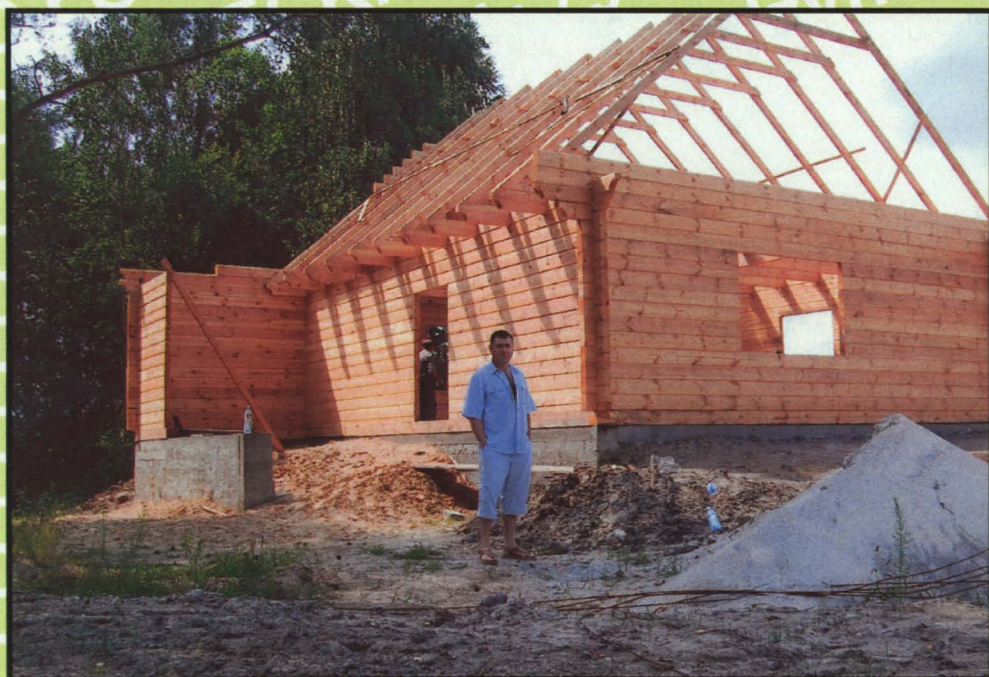
Na budowie stacji myśliwskiej w Łózkach (2007 r.).
