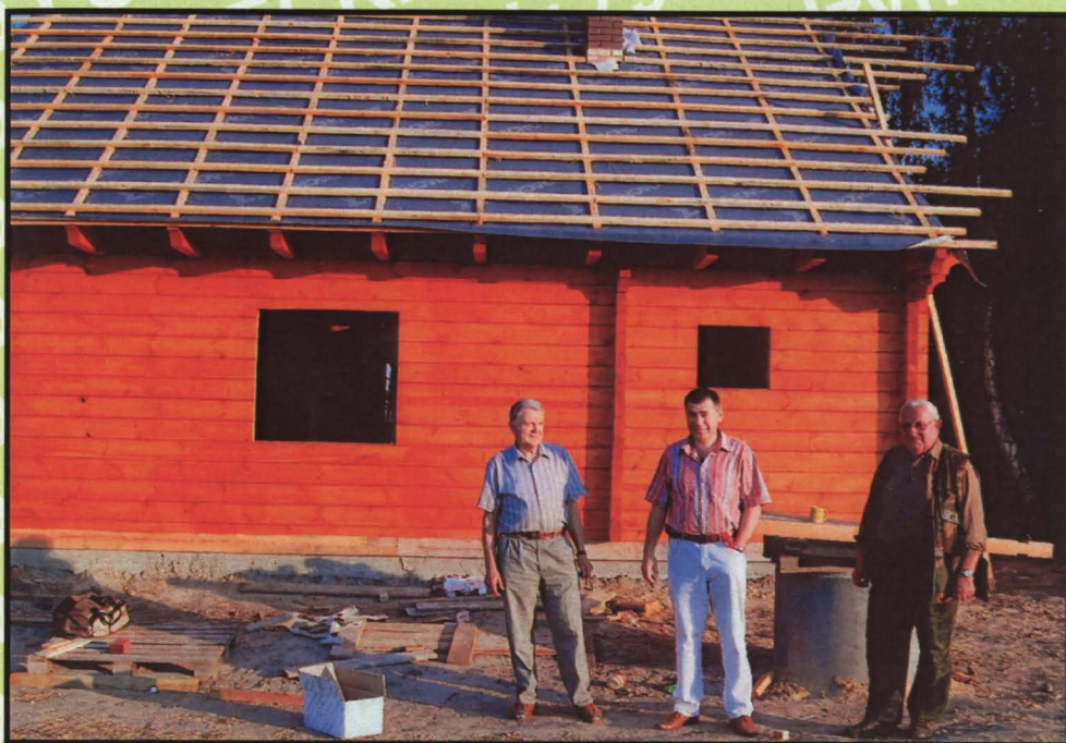
Na budowie stacji myśliwskiej w Łózkach (2007 r.).
